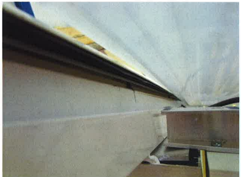
Polycarbonate sorti de sa feuillure sur le côté droit
